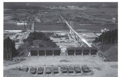
土砂を運搬するベルトコンベア (©陸前高田市 東日本大震災記録誌)
