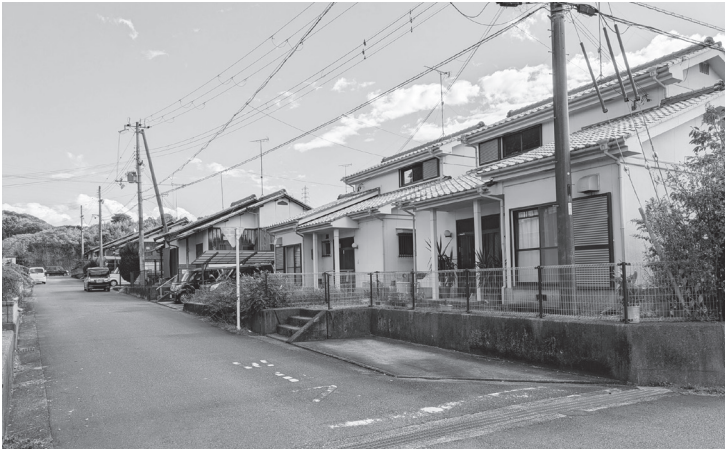
木造の町営住宅（2戸連）
